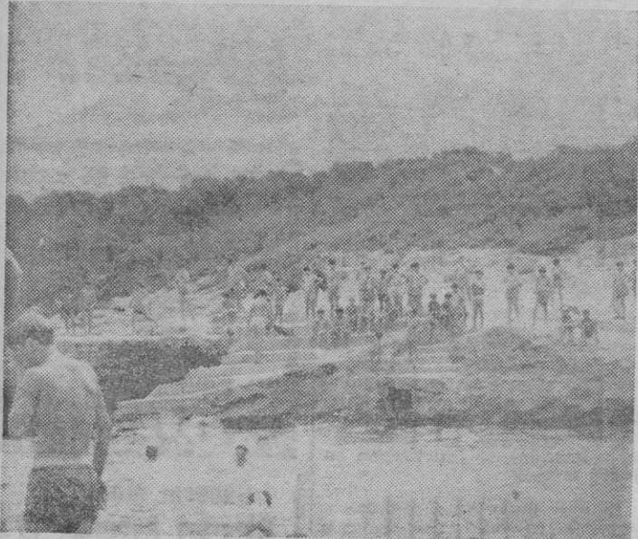
UNA PANORAMICA DEL ESTADO DEL "SOLARIUM" DEL CAMPAMENTO
