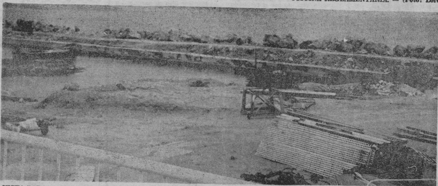
VISTA PARCIAL DEL ESPIGON DE 250 METROS DE LONGITUD QUE SE ESTA CONSTRUYENDO PARA EMBARCACIONES DE MUCHO CALADO, PREFERENTEMENTE YATES. HACE AÑOS QUE SE ANHELABA ESTA REALIZACION, PORQUE ERA DE URGENTE NECESIDAD. — (Foto: Lorenzo Ripoll).
