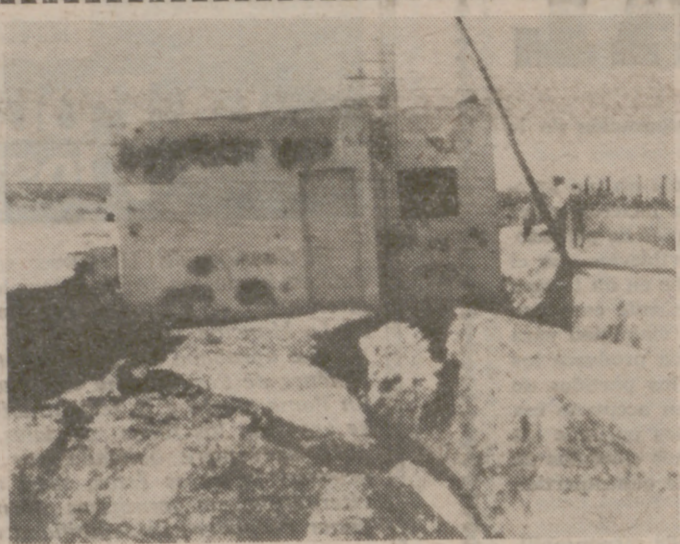
PROVINCIA DE SAN JUAN (Argentina).—Enormes grietas rodean esta casa, que se hundió varios metros a causa del terremoto, causando la muerte a docenas de personas.
