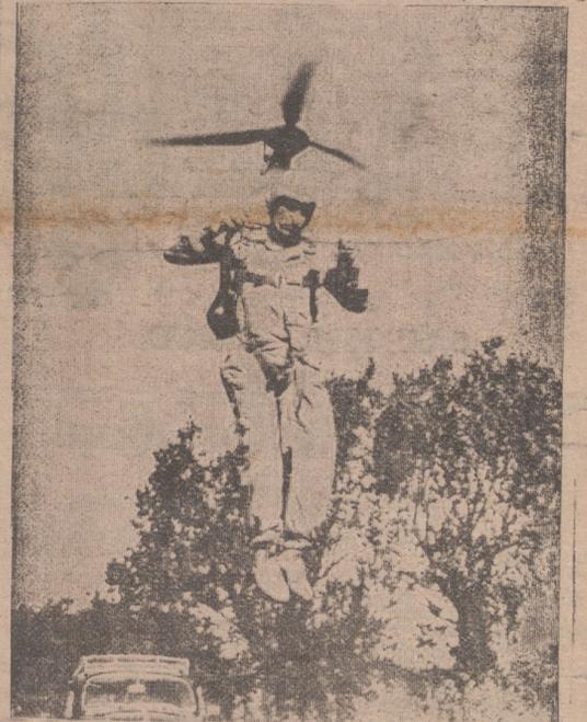
El constructor danés Vincent Seremet, de Copenhague, de 35 años, ha construido un helicóptero individual que espera poder fabricar en serie al precio de unos 9.000 kroner (72.000 pesetas). Está dotado de un motor de 15 caballos de potencia y el rotor tiene un diámetro de tres metros. Seremet cree que su helicóptero puede ser una solución para los desplazamientos rápidos, pero no espera que sea adoptado por personas privadas, pero podría dar buenos resultados para los bomberos y militares.
