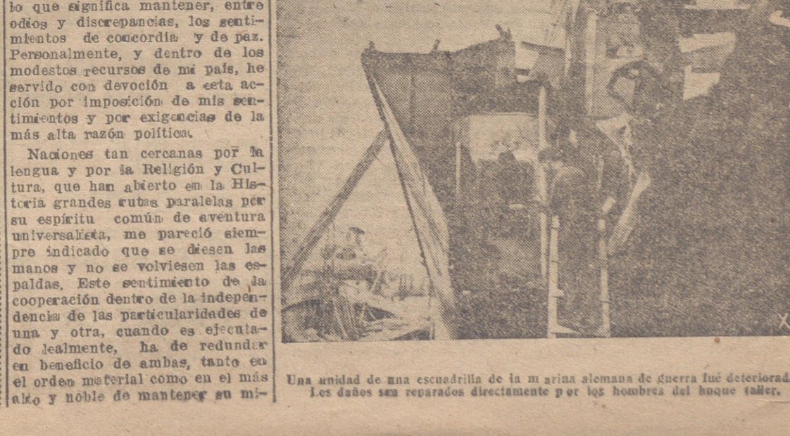
Una unidad de una escuadrilla de la marina alemana de guerra fué deteriorada. Los daños son reparados directamente por los hombres del buque taller.
