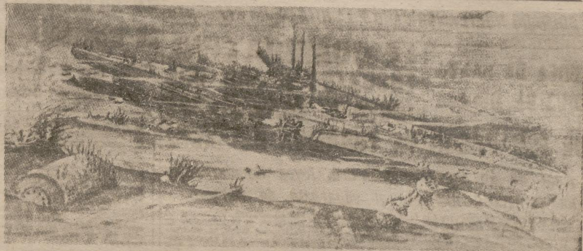
He aquí un dibujo que muestra la situación exacta en que se halla el "U-853" después de quince años de permanencia bajo las olas. Los dos agujeros que aparecen en la banda de estribor y en la cubierta determinaron el hundimiento. El casco aparece cubierto de vegetación submarina. Alrededor pueden verse cargas de profundidad y otros proyectiles sin estallar. (Foto Fiel.)
