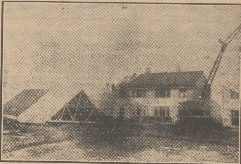
Las teorías del método Mulberry, para la construcción de casas en serie, antes aplicado solamente a las casas desmontables o provisionales, se está empleando ahora con eficacia en las casas permanentes, a base de cemento armado. El tejado se construye separadamente por obreros especializados y luego se monta en la casa por medio de grúas. (Foto Gil del Espinar.)
