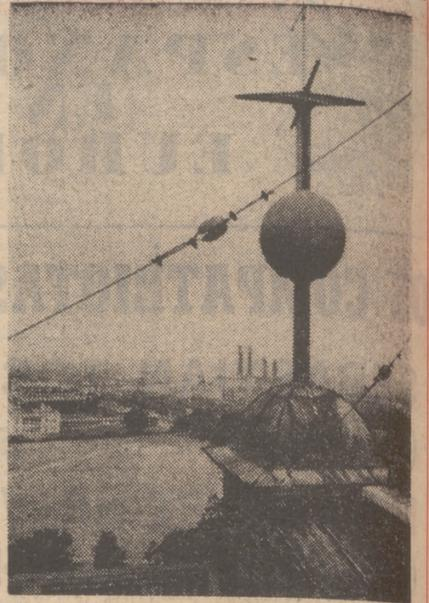
En una de las torretas de la Escuela Naval de Greenwich, la bola del tiempo tiene un peso simbólico al deslizarse de la parte superior de su mástil
