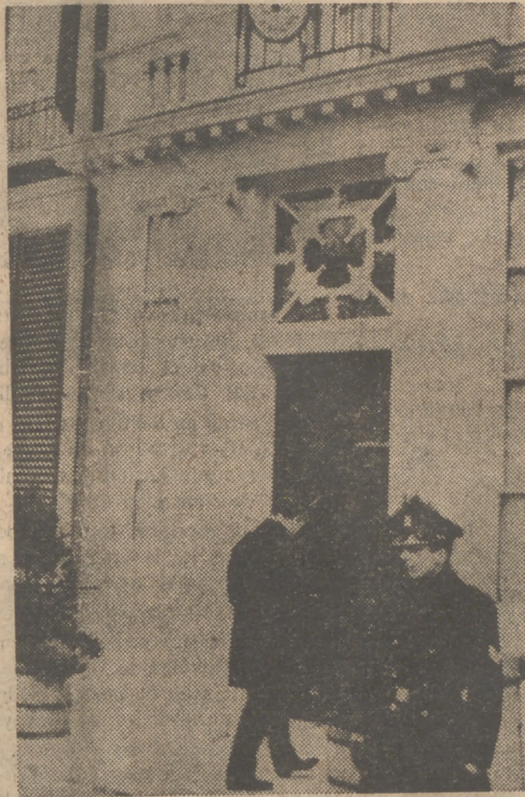
ROTURA DE CRISTALES.—Los únicos desperfectos producidos por la explosión registrada ante la Embajada de España en La Haya fueron estos cristales rotos
