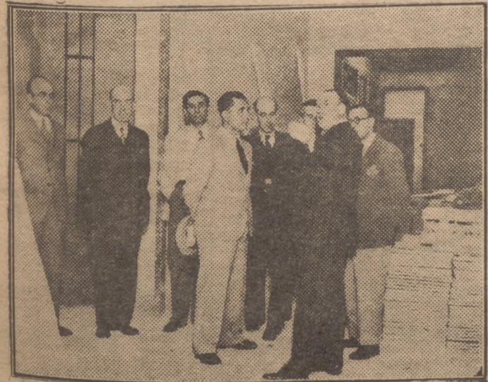
El Excmo. Sr. Gobernador Civil en su visita a las obras en construcción del Círculo Mercantil
