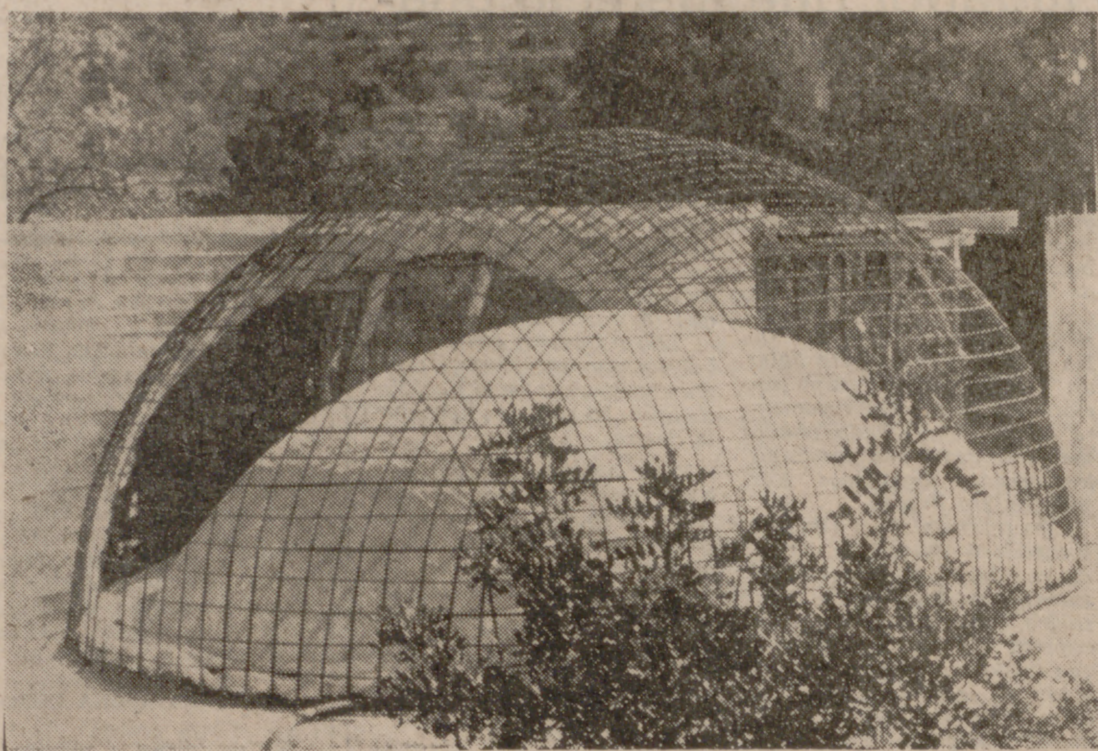
Etapa del encofrado con la malla metálica.
