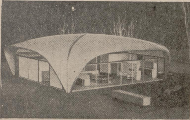
Elemento de superficie compuesta que constituye techo y estructura portante. (Foto PYRESA.)
