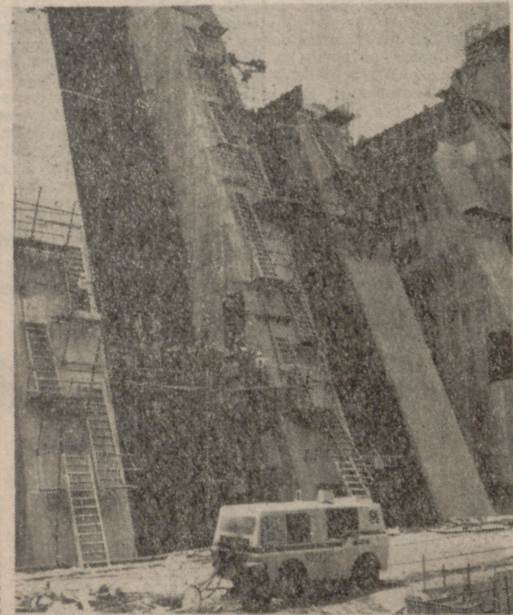
Trabajos en la presa de Inga. — (Foto PYRESA.)
