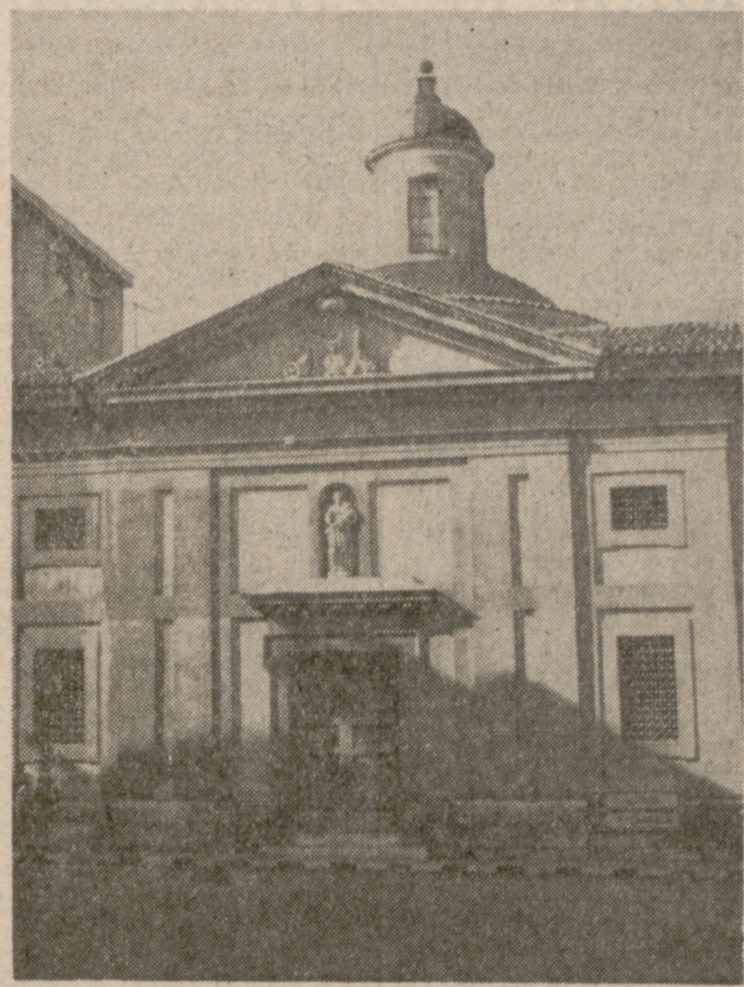
Facienda del convento de Santa Ana sobre parte del solar de la Trinidad. Fue construido bajo la dirección del arquitecto Sabatini e inaugurado en 1787. Guarda, que se ve, tres Bayas —los que están en el lado de la Epistola— y tres Bayas de escasa importancia, éstos. En la clausura existen otros que por los años inmediatos a la exclaustración de Mendizábal, sustituyeron las monjas por los originales del barrio de Fuendetodos.
