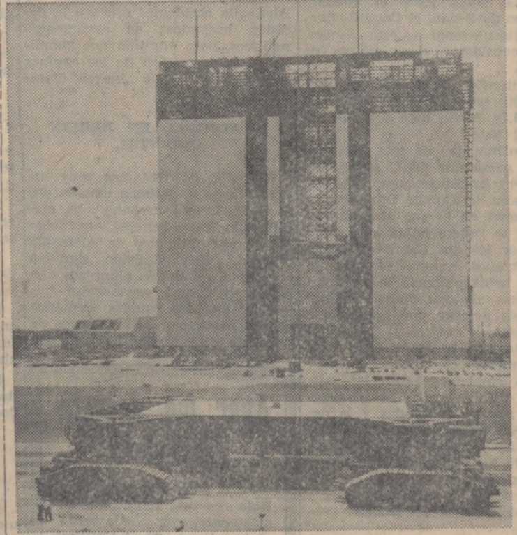
El enorme transportador sobre orugas (primer plano), de tres mil toneladas de peso, destinado a conducir a la plataforma de lanzamiento el cohete lunar “Saturno V”, es sometido a prueba en Cabo Kennedy (Florida). Al fondo se ve el edificio vertical de montaje, donde se armará el cohete, de 90 metros de altura, y donde asimismo se armará e inspeccionará el vehículo “Apolo” antes de su viaje de cinco kilómetros a la zona de lanzamiento. El transportador se mueve a una velocidad de unos dos kilómetros por hora.
