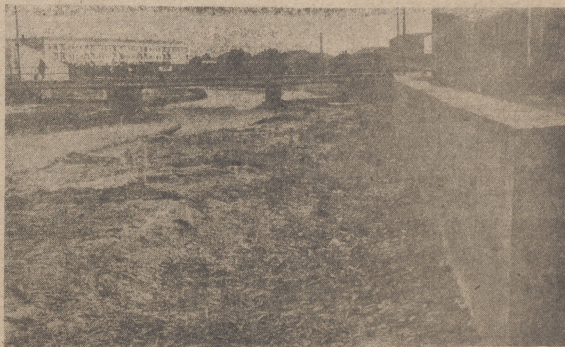
El famoso puente de la Pilarica. No hace muchos años todavía, con el del ferrocarril y el sifón de Garazabal, eran los principales obstáculos promotores de catástrofes en Valladolid. Ahora, con excepción del "puente de la vía", testigo también de muchas tragedias, no hay ninguna dificultad para el desagüe del Esgueva en los días de avenidas extraordinarias. Modificado el puente que muestra el grabado, con más luz, una sección y una rasante capaces de admitir noventa metros cúbicos por segundo, cifra desconocida todavía por el río de tantos sinsabores para la historia de Valladolid. A la derecha de la foto está el muro contiguo a la calle de la Polvora.
