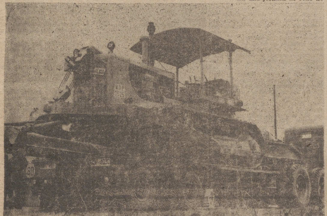
Tractor «Caterpillar D-8», con angledocer para movimiento de tierras. — (Foto Confederación Hidrográfica del Duero).
