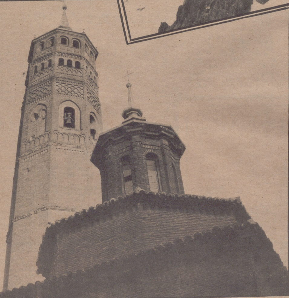
IGLESIA DE SAN PABLO - (Zaragoza) J. I. Laguna C.
