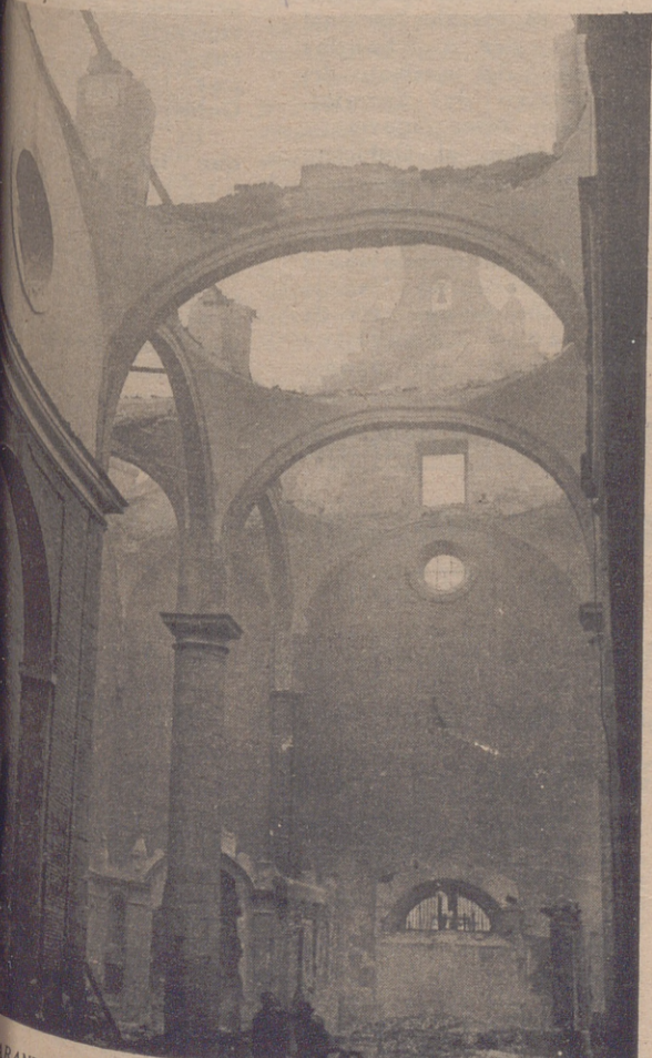
IGLESIA DE BRACAMONTE (Salamanca).— Estado en que quedó la iglesia de San Miguel después de ser destruida por el fuego en la pasada noche. A pesar de los esfuerzos del vecindario, de la Guardia Civil y de los bomberos de Valladolid y Avila, el fuego no pudo ser sofocado y se consumió la techumbre. (Foto Europa Press).
