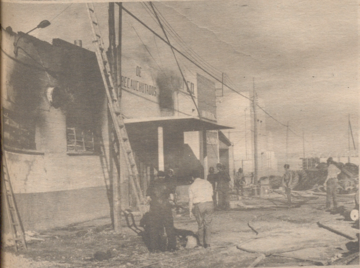
Así quedó la fachada de la fábrica de recauchutados "Herca". Después del pavoroso incendio de ayer tarde. La huella del siniestro queda patente allí, mientras que, sobre sus paredes negras, se apoyan esas escaleras de emergencia que, por su fragancia, ya no pueden conducir a parte alguna.
