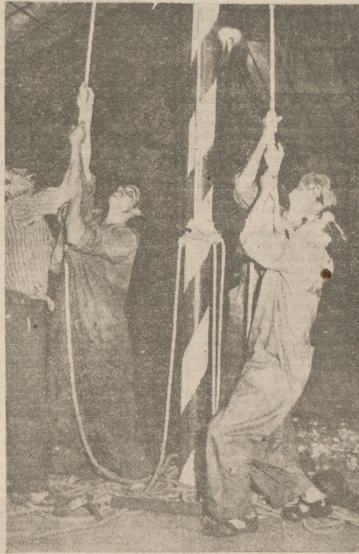
La parte más difícil de la construcción: el mantener completamente vertical esta viga de hierro de quinientos kilos de peso y dieciséis metros de larga. (Foto Carvajal.)
