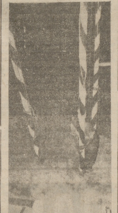
Ocho metros tiene cada uno de estos paños. Ellos servirán de sustentación a la inmensa lona que recubre el circo. Como ellos, cuarenta circundan el recinto. (Foto Carvajal.)
