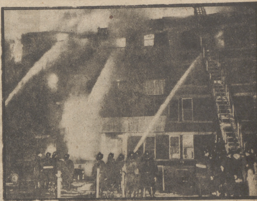
INCENDIO EN FRANCIA.—Un edificio enclavado en los alrededores del puerto de Ivry, dedicado a almacén de muebles, ha quedado reducido a cenizas después de ser devastado por un incendio que ha durado más de tres horas, en cuya extinción han intervenido los bomberos de doce parques y dos barcos-bomba anclados en el puerto. Las pérdidas, enormes, no han podido ser cifradas todavía. En nuestra fotografía se ve al señor Damoy, propietario del inmueble en cuestión, contemplando lo que ha quedado de su edificio
