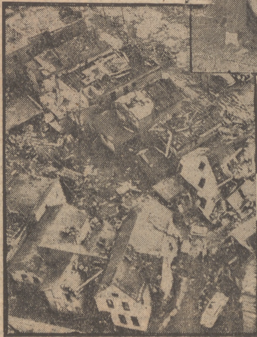
Una vista aérea de la ciudad de Cleveland, una de las más afectadas por los recientes tornados padecidos en varios Estados de Norteamérica
