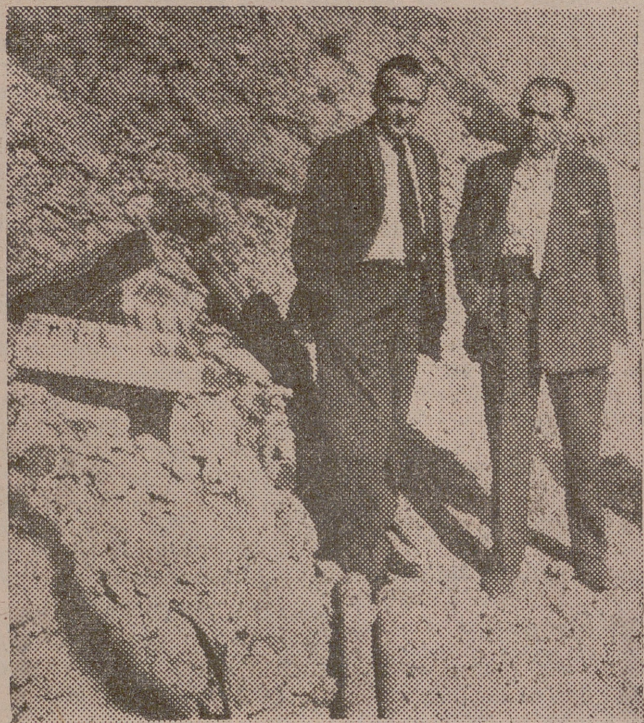
Don Juan Antonio Martínez Bretón, presidente de la Diputación Provincial, y don Marino Martínez Gurrea, ingeniero-director de la Sección de Vías y Obras, inspeccionan las obras del cerro Cantabria, de las que son promotor y realizador.
