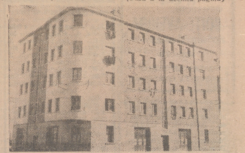
Grupo de 32 viviendas subvencionadas en el Camino de Madre de Dios, del que es promotor el Sr. Marín Calavia.
