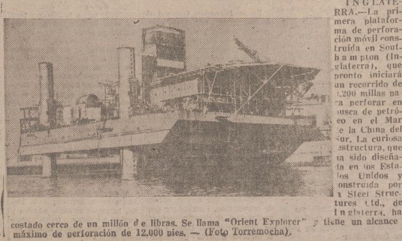
costado cerca de un millón de libras. Se llama "Orient Explorer" y tiene un alcance máximo de perforación de 12.000 pies. — (Foto Torrecocha).
