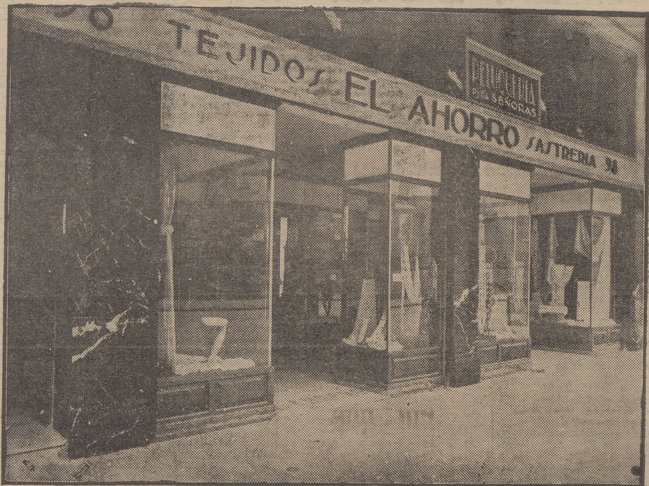
PORTADA DEL ESTABLECIMIENTO CON SUS ESCAPARTES DEL FRENTE DEL MISMO
