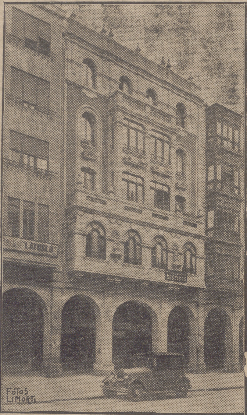
FACHADA DE LA MAGNIFICA CASA, PROPIEDAD DE D. MANUEL BARRIO, EN CUYOS BAJOS HA INSTALADO SU COMERCIO "EL AHORRO"
