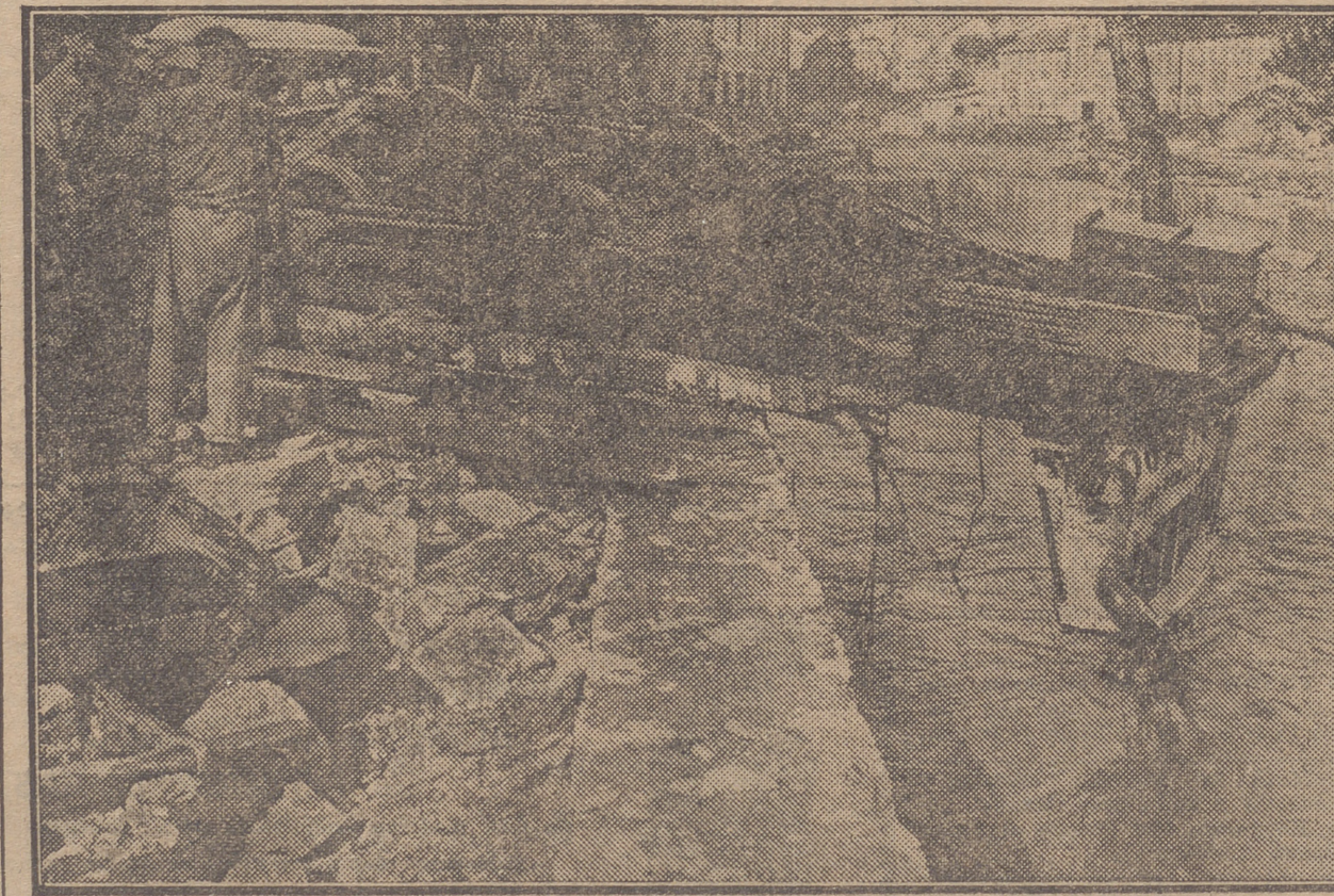
RENTERIA.—Estado en que quedó uno de los tranvías sorprendido por la inundación. La riada se zarrandó y volcó sobre el muro que contenía al Oyarzun. (Photo Carte)
