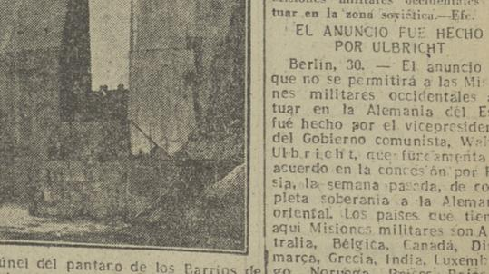
Con la perforación total del túnel del pantano de los Barrios de Luna, para la central de pie de presa que se construye allí, ha concluido una importante fase de las obras, de las que ofrecemos una vista general. Este túnel tiene una longitud de 3.700 m. y ha sido excavado en la roca. La central, cuya puesta en marcha se confía para principios del próximo año tendrá una producción de cien millones de kilovatios hora.
