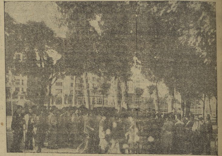
El cliché recoge un momento de la subasta de terrenos para la instalación de barracas. Por el sistema de puja se adjudican los solares, y siempre un numeroso público asiste a esta sencilla operación
