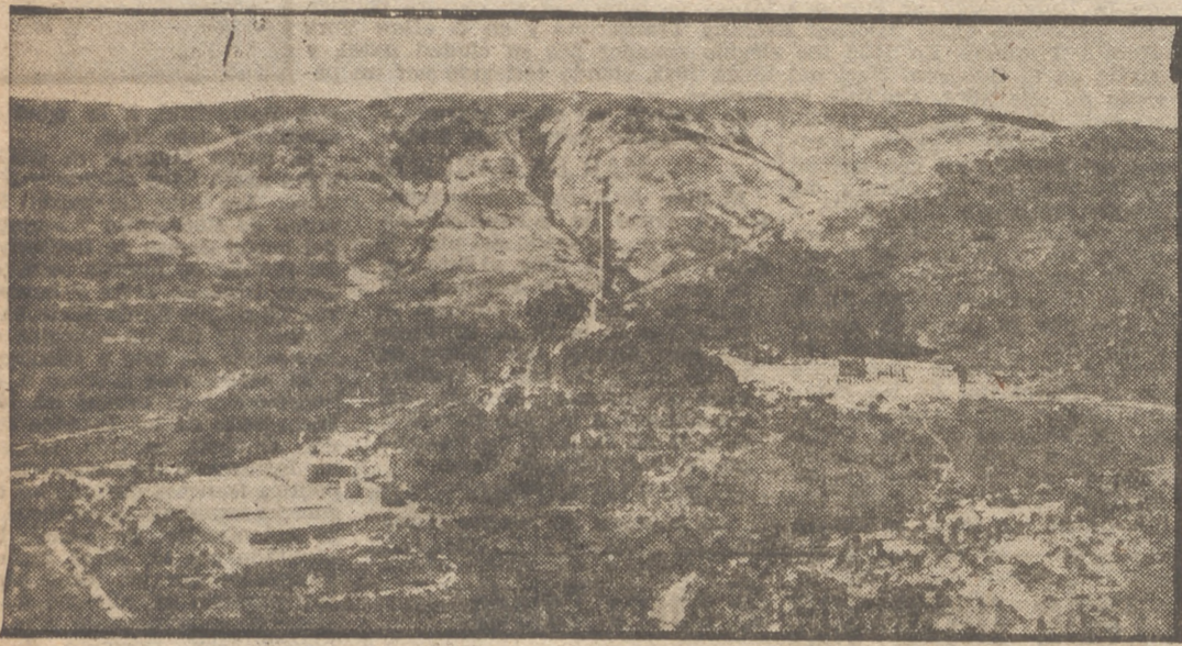
Vista del núcleo central que forman el Monasterio, la Hospedaria y el Centro de Estudios Sociales del Valle de los Caídos en Cuelgamuros, cuyas obras están ya a punto de quedar terminadas
