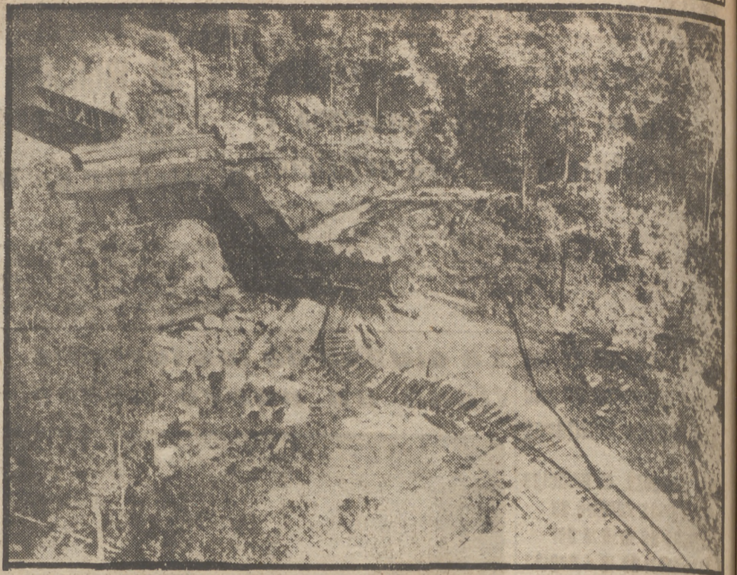
Las aguas desbordadas causaron el descarrilamiento
