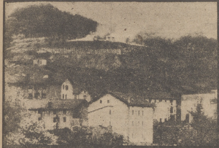
Al fondo se ve el edificio humeante de la fábrica de bombas incendiarias de la Unión Española de Explosivos, en Zuazo, cerca de la localidad bilbaína de Galdacano
