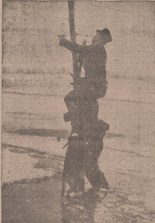
Las líneas telefónicas alemanas sobre un ancho río del frente del Este fueron cortadas por una violenta tormenta. Soldados de transmisiones, introducidos en el agua helada hasta la rodilla, arreglan la avería.
