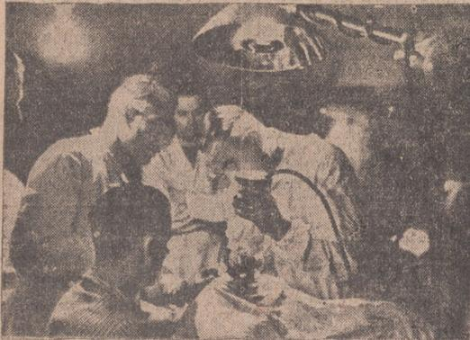
Electromagneto, empleado para extraer los trozos de metralla del cuerpo. Primeramente, por medio de los Rayos X se localiza el lugar en que se encuentra la metralla. Luego basta un ligero corte con el bisturí y el electromagneto extrae rápidamente y sin esfuerzo el cuerpo extraño.
