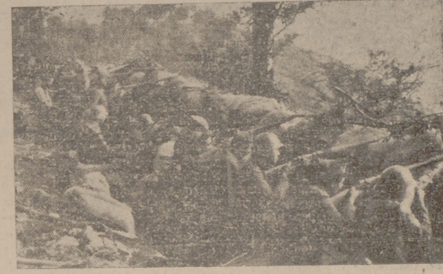
Una línea de trincheras de los nacionales
