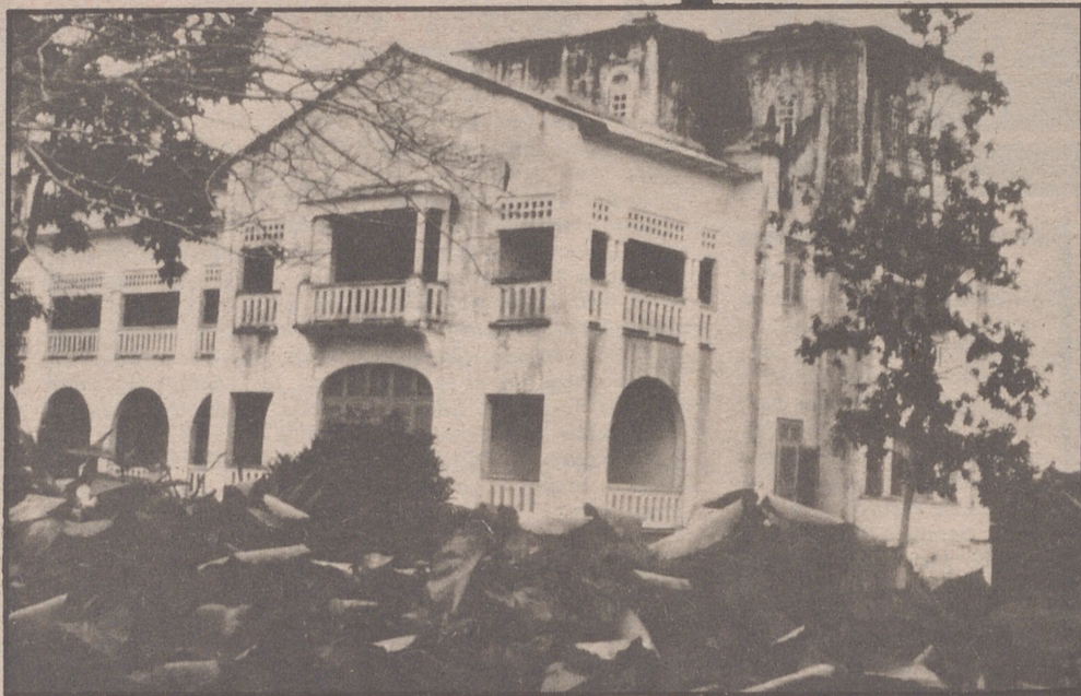
En este estado de abandono y ruinas se encuentra el Hospital Español situado en la capital guineana (Foto Efe)
