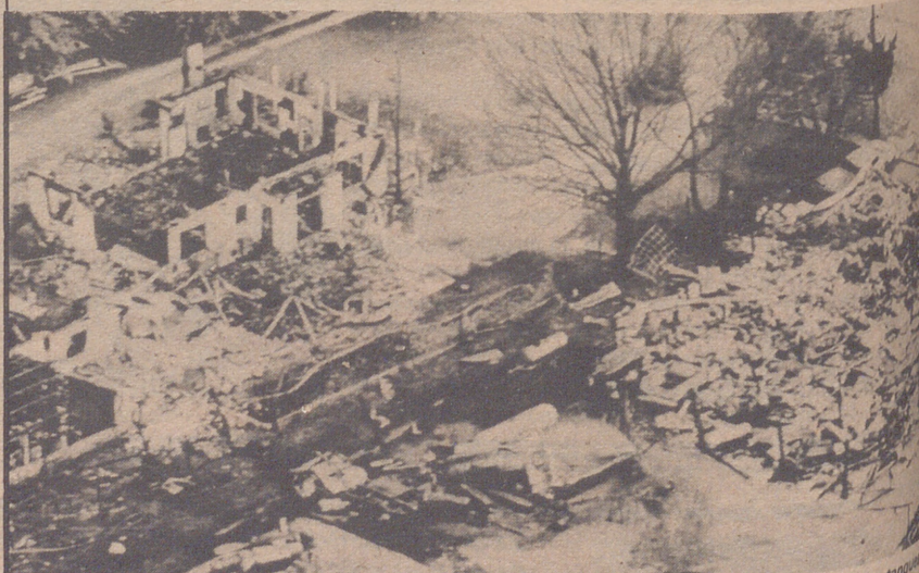
JAY (Florida). — Vista aérea de la zona, donde se produjo la explosión de dos tanques de 300.000 litros de gas licuado, cada uno. En el siniestro no hubo que lamentar víctimas, pero sí bien la pequeña oficina de la compañía de gas quedó totalmente destruida, y una casa que se encontraba en las inmediaciones (izquierda), también fue pasto de las llamas. (Telefoto Efe).
