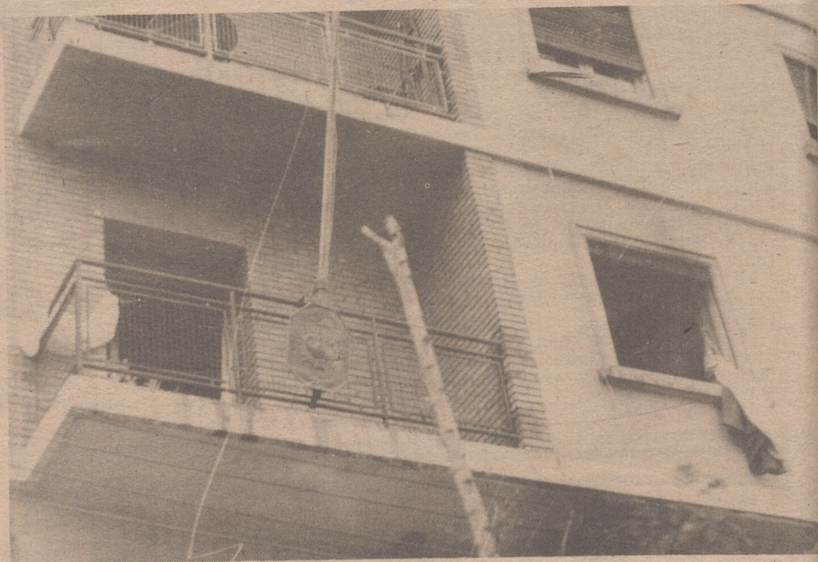
Este es el segundo piso del número 3 de la calle La Salle. La fachada del Consulado francés, presenta este aspecto. Cristales rotos, cortinas hechas jirones y paredes ennegrecidas...
