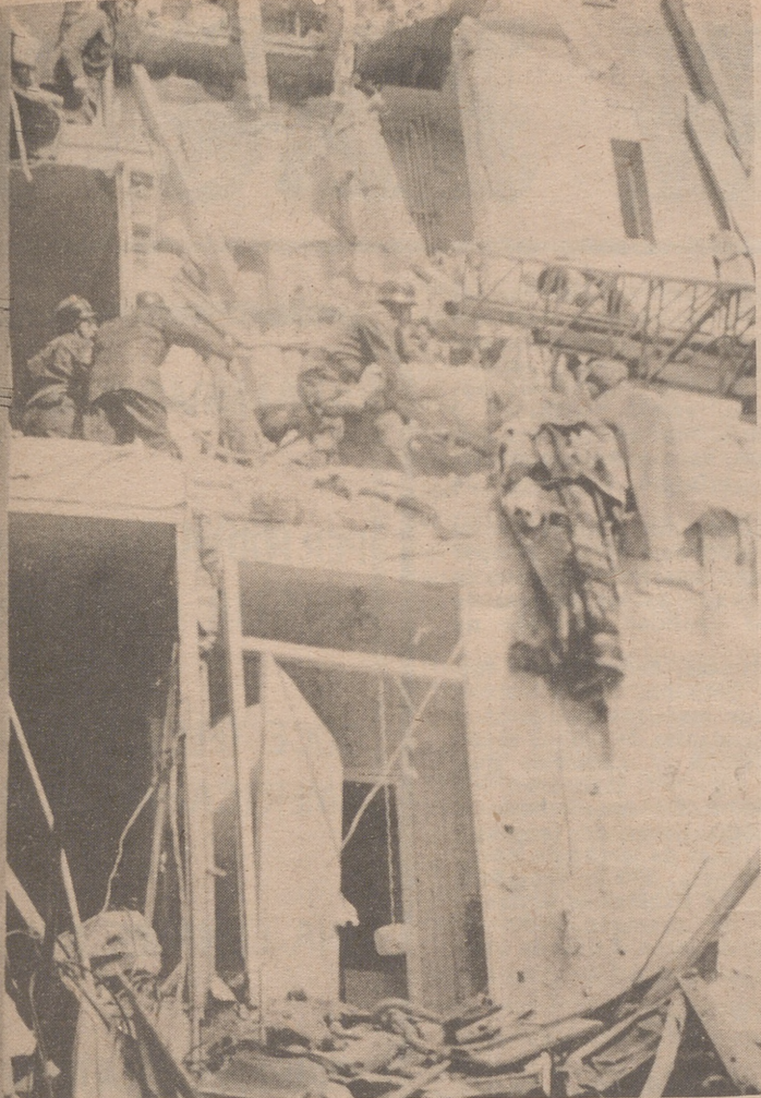
BARCELONA.— Con ayuda de una escalera, los bomberos proceden a rescatar otra de las víctimas registradas al hundirse un ala de un edificio de diez plantas. Con éste eran catorce los cadáveres encontrados. (Foto Europa Press).
