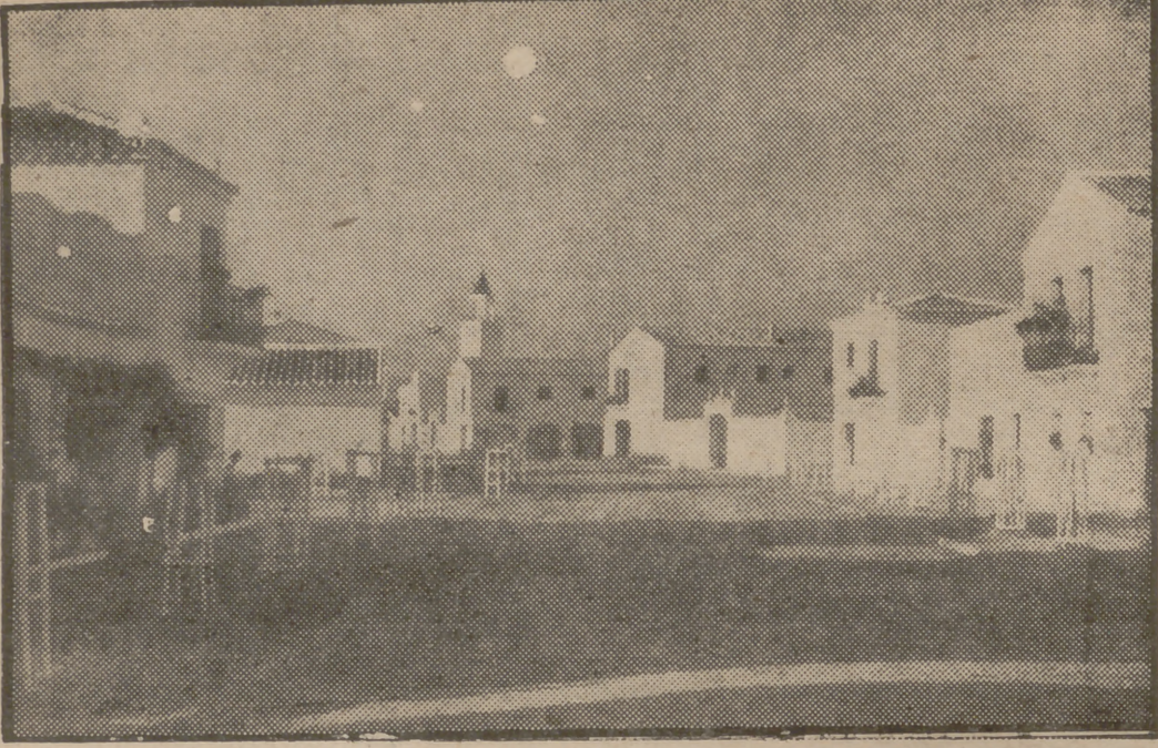
Una calle del nuevo pueblo de La Barca de la Florida (Jerez de la Frontera)
