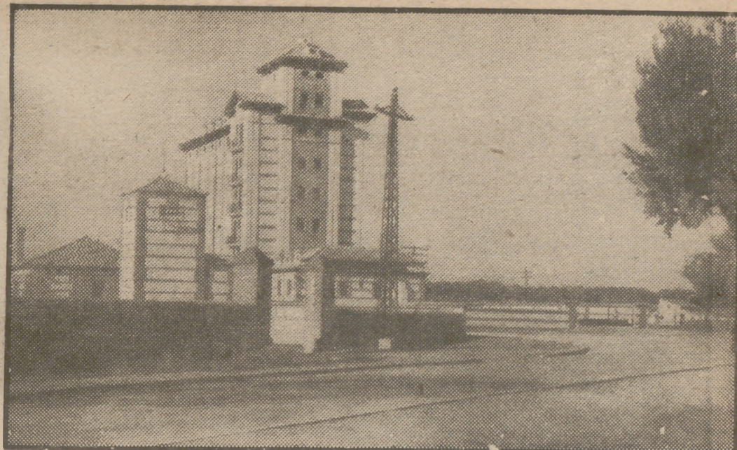
SILO DE ALCALA DE HENARES
