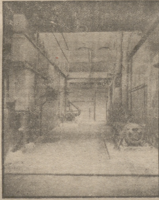
DETALLE DE LA SALA DE MAQUINAS DE LA GRAN FABRICA DE PRODUCTOS QUIMICOS SCHERING, EN MENDEZ ALVARO, 57
