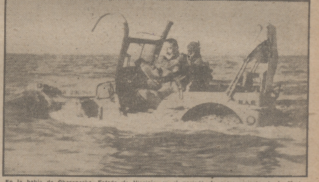
En la bahía de Chesapeake, Estado de Virginia, en el período de entrenamiento de la Marina norteamericana, se han hecho pruebas satisfactorias con un nuevo modelo de "jeep" anfíbio, que marcha con sólo la "cabeza" sobre la superficie del agua. La fotografía recoge un momento de la prueba del nuevo vehículo. (Foto A. P.)
