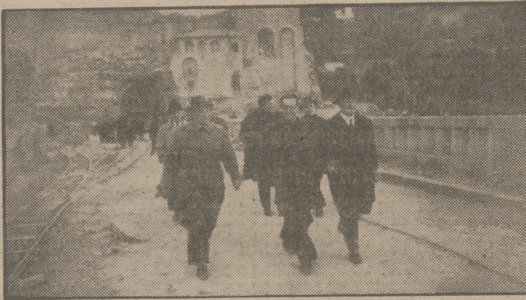
El Delegado Nacional de Sindicatos sale del túnel que hay sobre la presa del pantano del Generalísimo, en compañía de don Miguel Abriat y del ingeniero señor Burguera. (P. L. Vidal.)
