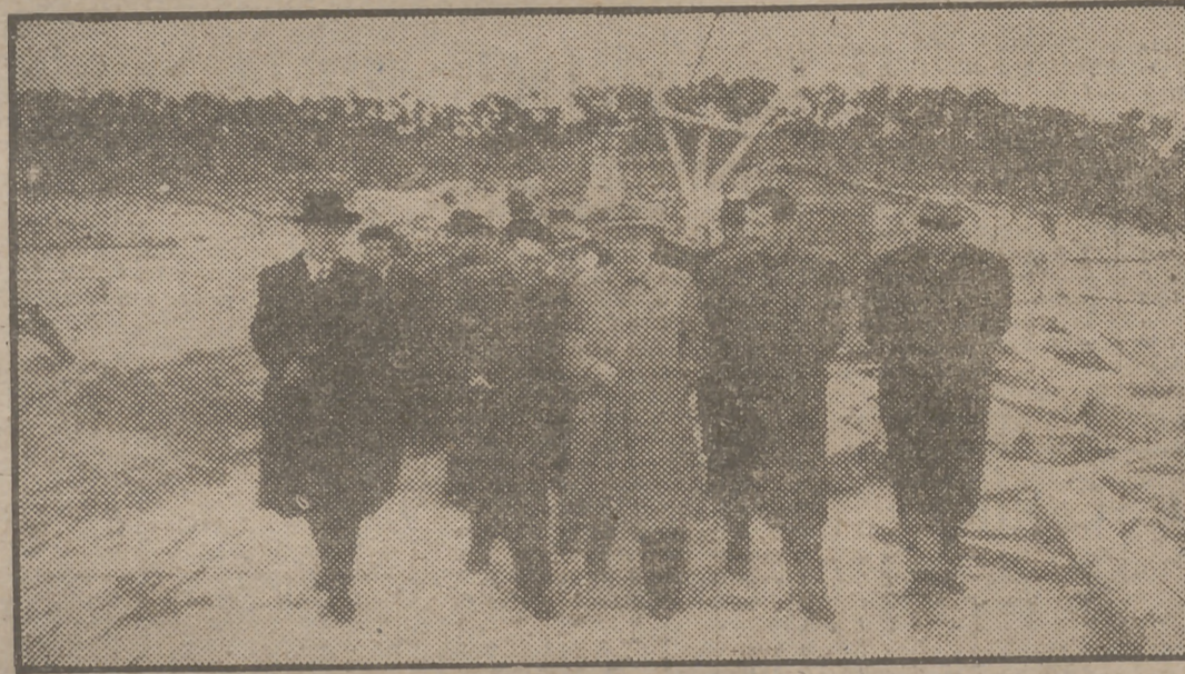
Fernín Sanz Orrío, acompañado del general Abriat, pasa por encima de la presa del pantano de Alarcón. Se está acabando el puente para el nuevo trayecto de la carretera de Madrid a Valencia. (Foto Luis Vidal.)
