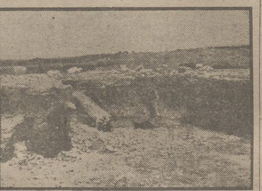
Estado actual del terreno donde estuvo el palacete.
