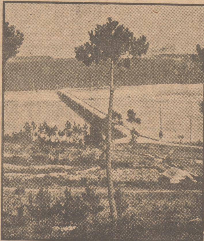
La Toja es una isla "natural" y una península artificial, cuyo istmo es el puente que aparece en esta fotografía, internándose en un bosque "tropical" de pinos.
