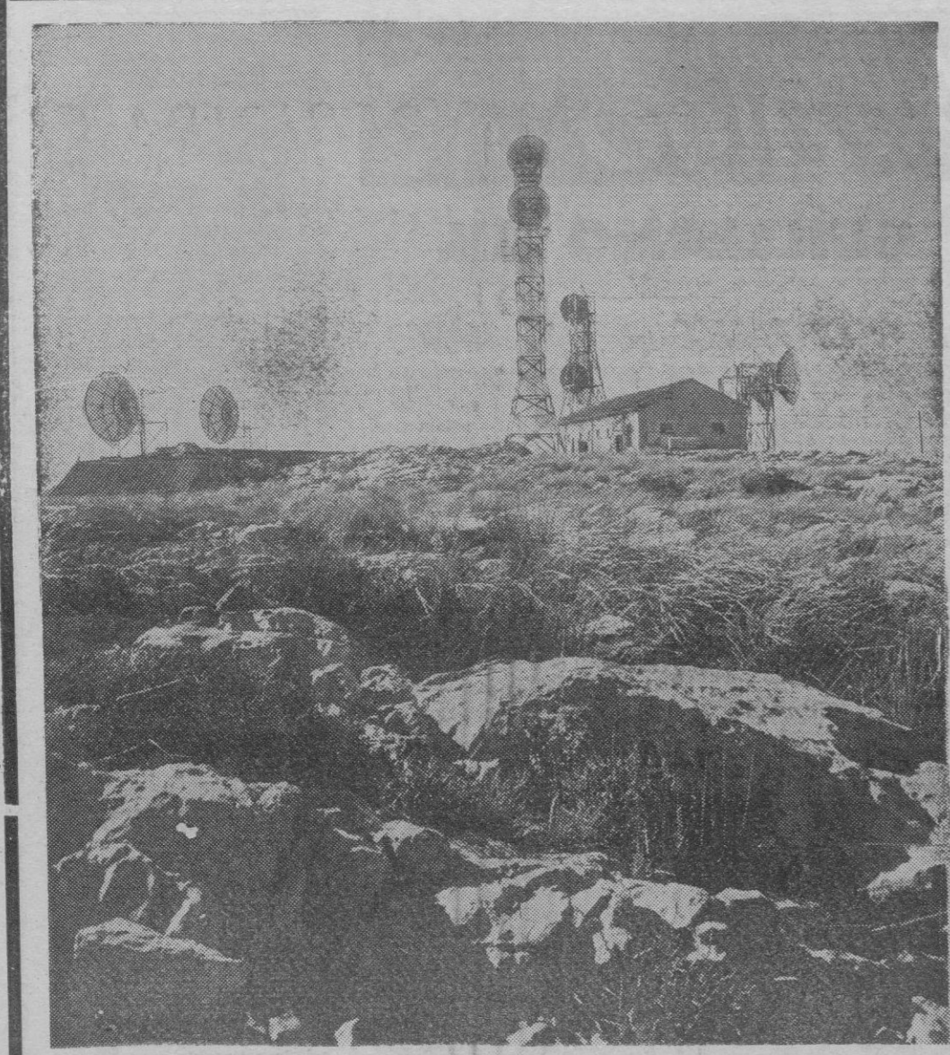
FOTO INEDITA DE LAS INSTALACIONES DE RADIO COMUNICACION DEL PUIG DE ALFABIA. EN ELLA APARECEN LOS ENLACES CON BARCELONA, IBIZA Y MAHON, A LA IZQUIERDA, LAS DOS ANTENAS PARABOLICAS DE LA RADIO COMUNICACION CON ARGELIA. ENLACE DIRECTO ENTRE ESPAÑA Y ARGELIA DESDE ESTE PICO MALLORQUIN. (Foto "Sal", Madrid)
