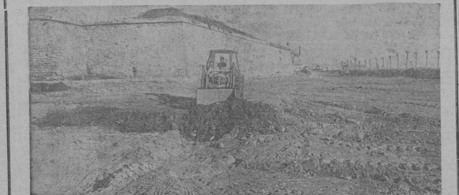
SOBRE ESTA FOTO OBTENIDA AYER, PARECE QUE EL COMIENZO DE LAS OBRAS DEL PARQUE DEL MAR ES COSA HECHA. POSTERIORMENTE HEMOS SIDO INFORMADOS DE QUE NO HAY TAL DE QUE ESTOS TRABAJOS NO PROSEGUIRAN. LÁSTIMA. — (FOTO TERRADES).
