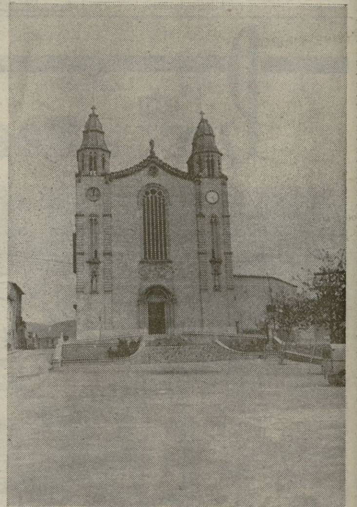
Esta es la plaza del Ayuntamiento —que está situado a la izquierda de la fotografía de «Juanets»— y que también puede denominarse plaza de la parroquia, pues ésta aparece al fondo. Este lugar será reformado muy en breve, por lo que ganará en belleza. El albañil que dirigió las obras de la fachada principal de la parroquia de Calviá fue Mestre Biel «Llisset». En Mallorca, floreció el siglo pasado una generación de maestros constructores que nos han dejado edificios de una gran solidez e incluso, si no de un depurado estilo, sí de cierta monumentalidad. Muchos de ellos, como el citado «Llisset» gozan de prestigio merecido.
