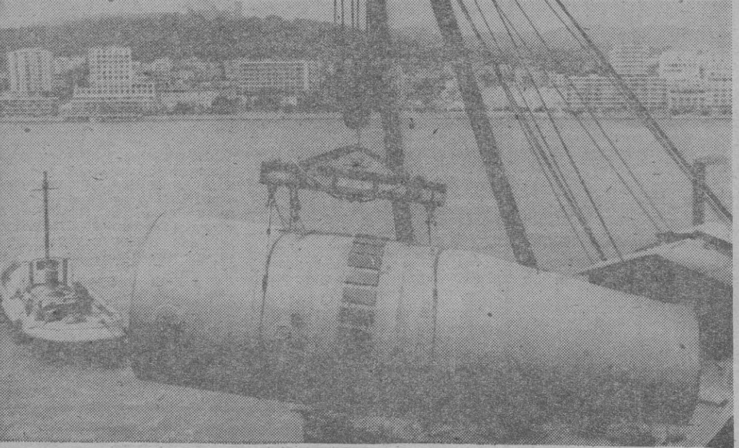
La descarga de los hornos y molinos rotatorios requirió el empleo de grandes grúas.
