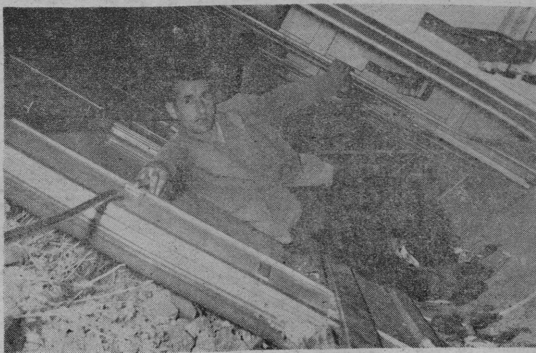
Este hombre, por espacio de más de una hora, permaneció tumbado en el suelo; y manteniendo con los pies la puerta, permitió la angustiosa salida de más de doscientas personas de uno de los vagones siniestrados en el descarrilamiento del expreso Madrid-Badajoz. — (Foto «Europa Press»)
