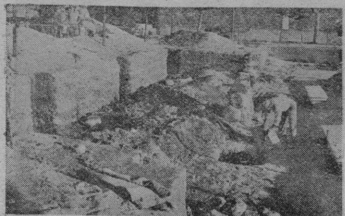
Dieron comienzo ya las obras de los nuevos vestuarios en el campo municipal de deportes de la Plaza de Berenguer de Palou. Las obras, al parecer, llevan un ritmo acelerado. (Foto Junnet)
